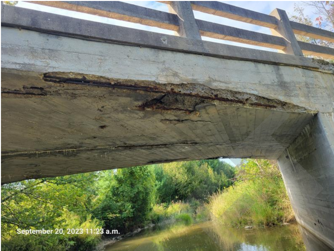
7-North Deck Edge
